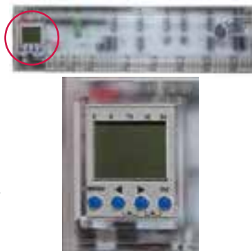
Unidad base de control termostático con salida para control de bomba y caldera.
